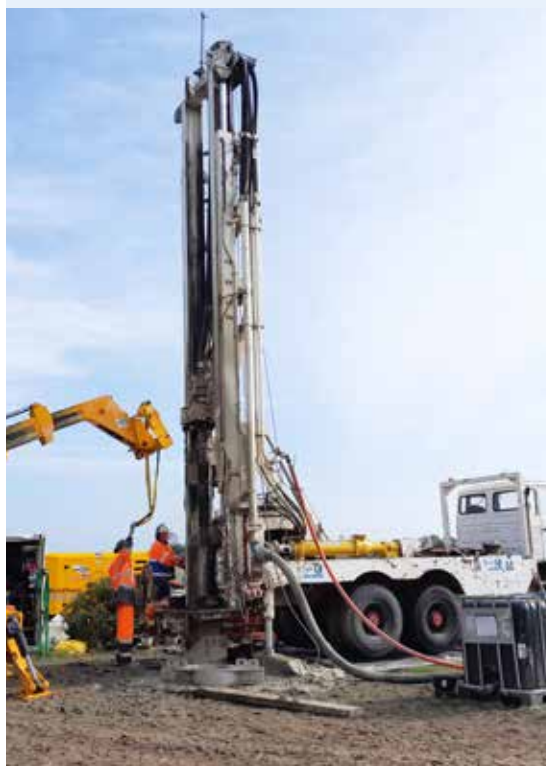
Nouveau forage à Massérac
